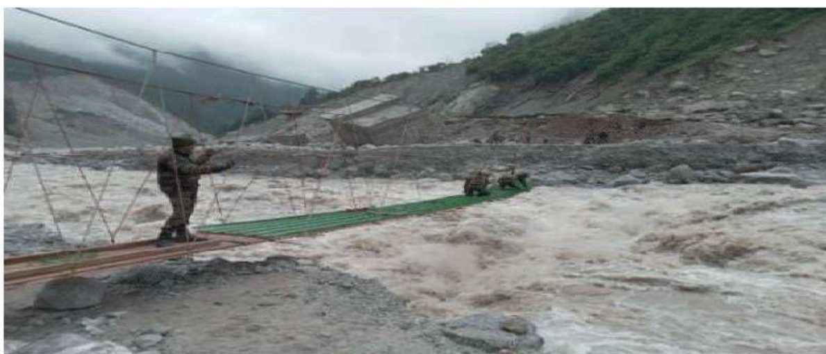
सिक्किम में अचानक आई बाढ़ के बाद पुनर्निर्माण कार्य
